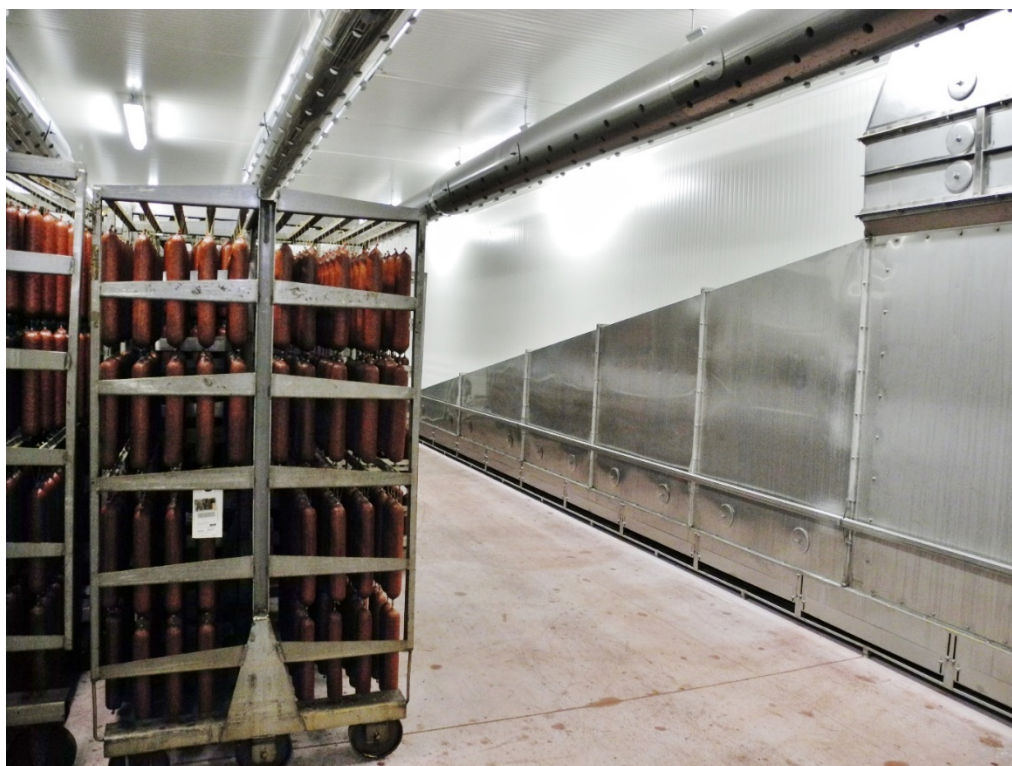
Obr 2: Ilustrativní fotografie: Pro rovnoměrný a efektivní proces sušení salámů hraje roli nejen přívod klimatizovaného vzduchu, ale také jeho odvod. Na snímku jsou instalace odvádějící vzduch z komory do klimatizační jednotky umístěné na pravé stěně, výrobce MAUTING KMD CrossFlow.
