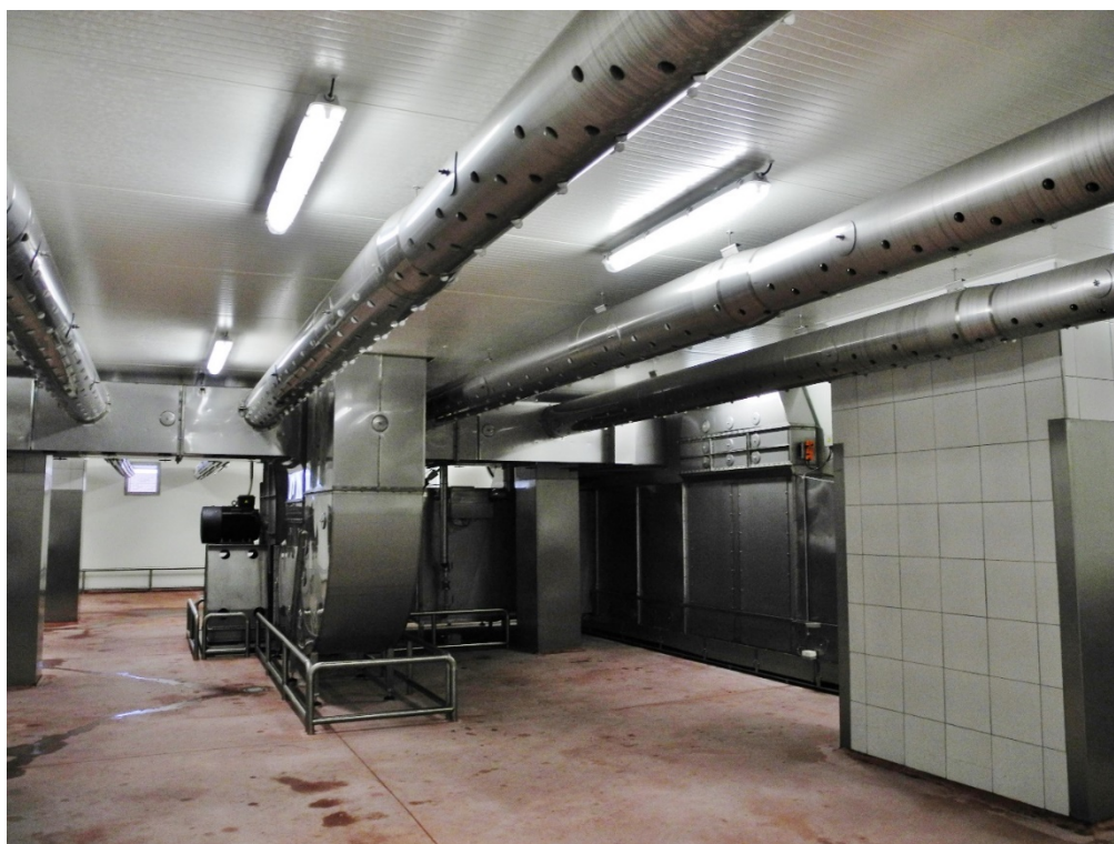
Obr 1: Ilustrativní fotografie: dozrávací klimakomora MAUTING KMD CrossFlow. Cílem konstruktérů a výrobců klimatizovaných komor je zajistit intenzivní ztráty vody během sušení salámů aniž by došlo ke vzniku kroužku nebo jiných vad. Důležitá je také rovnoměrnost sušení napříč celou komorou.
